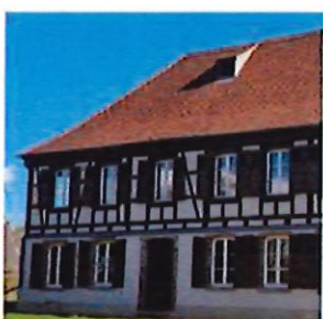
Rénovation de l'auberge
