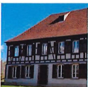
Rénovation de l'auberge
