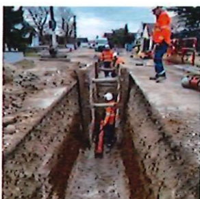
Pose du réseau d'assainissement
