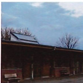
Etanchéité du toit de l'école
