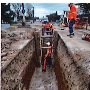
Pose du réseau d'assainissement
