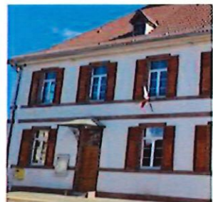
Rénovation des salles de classe
