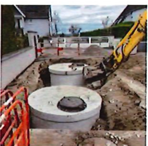
Traitement des Eaux Pluviales
