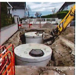
Traitement des Eaux Pluviales
