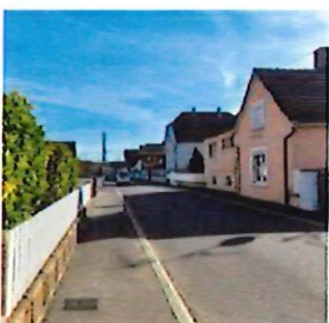
Voiries et trottoirs
