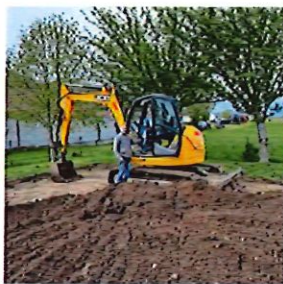
Rénovation des Mille Pattes
